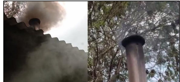
Gambar 7 Visualisasi dari emisi instalasi awal (kiri) setelah modifikasi (kanan) Sumber: Dokumentasi
